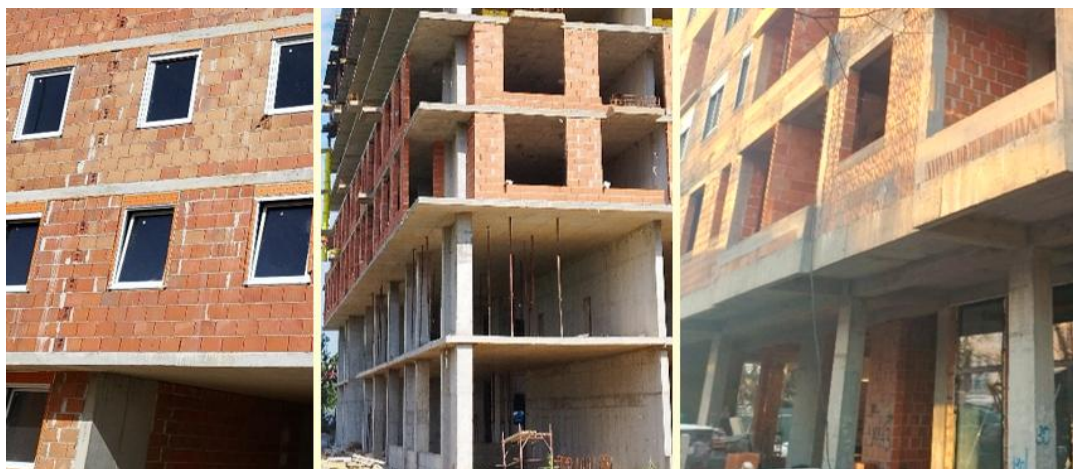
Figure 1. AB konstrukcije zgrada sa zidanom ispunom (fotografisao autor).
