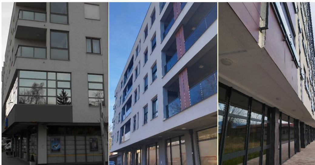
Figure 6. Primjeri tipičnog izgleda zgrada u Banjoj Luci – prizemlja imaju poslovnu, a spratovi stambenu namjenu (fotografisao autor).
